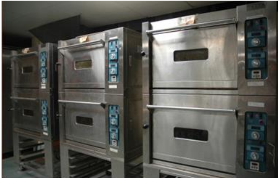
西餐二教室-烤箱設備
