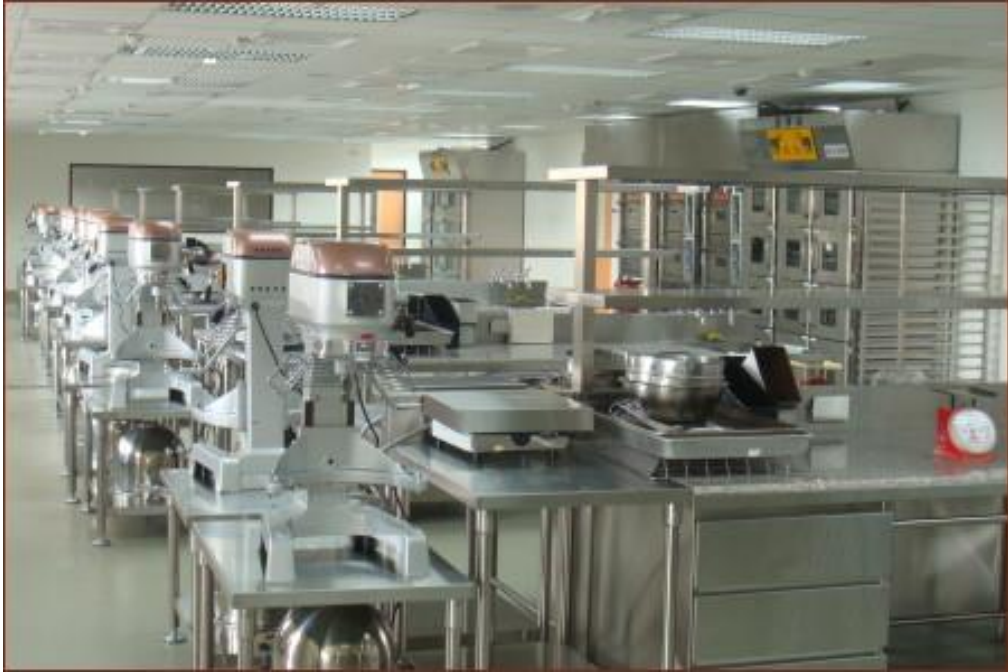
烘焙教室-攪拌機設備
